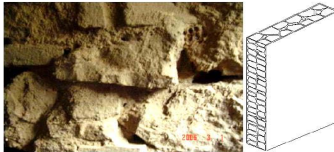
Fig. 13: Le mode constructif
