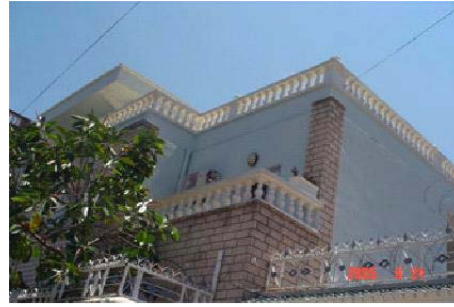
Fig. 7: Vue- Face de la villa Nord-Est, coté rue
