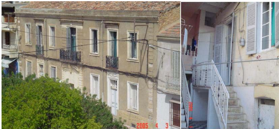
Fig. 2: Vue-facade Sud-Ouest (côté rue) – Vue-facade Nord-Est (côté cour)
