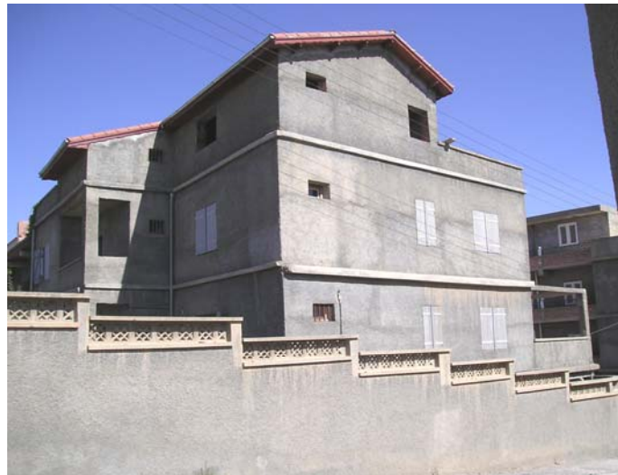
Fig. 4: Vue coté Nord et coté Ouest de l'habitation étudiée
