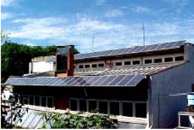
Fig. 1a: Modules installés sur le toit du laboratoire
