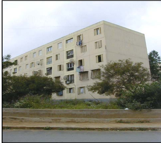
Fig. 3: Façade Est de l'immeuble étudié
