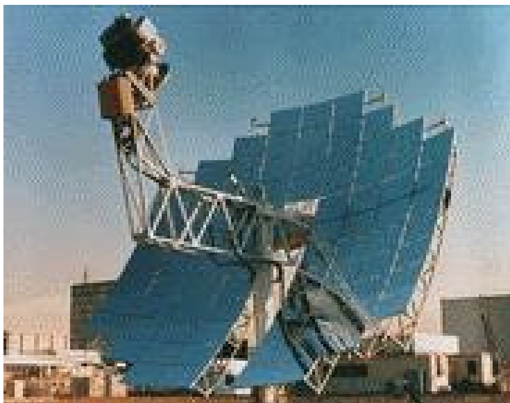
Fig. 2 : Le système McDonnell Douglas/Southern California Edison, produisant 25 kW e .
