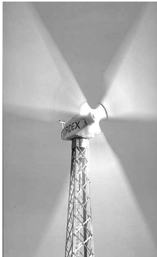
Fig. 1: pylône en treillis
