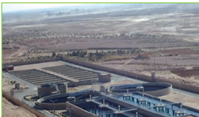
Station d'épuration des eaux usées « STEP de Laghouat »
