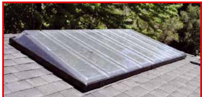
Figure 2 . Chauffe eau solaire avec vitrage thermoformé [2]
