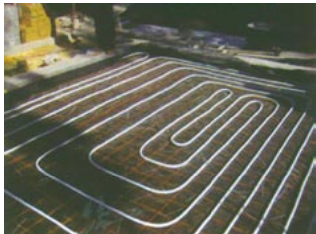
Mise en place de l'échangeur de chaleur.
