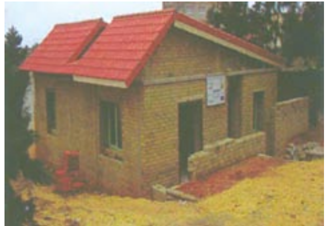
Projet pilote: Logement efficace en énergie
