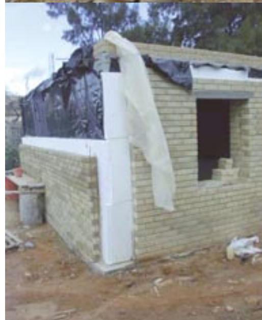
Opération isolation des parois
