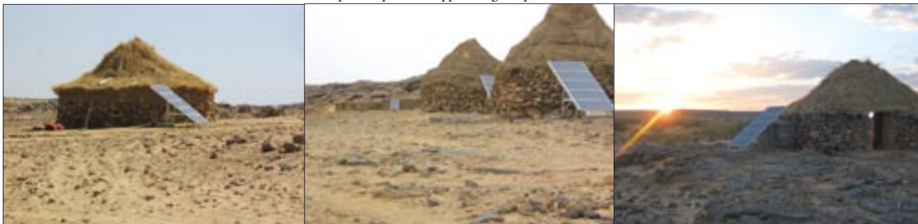
Vue d'ensemble des générateurs photovoltaïques installés
