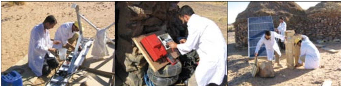
Installation en cours du générateur photovoltaïque
