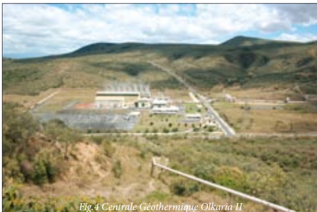
Fig.4 Centrale Géothermique Olkaria II
