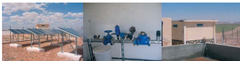
Exemple de système de pompage PhotoVoltaire réalisé
