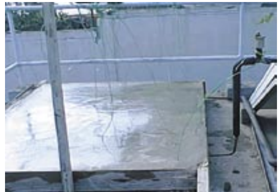
Coulage de la dalle au-dessus de la grille de chauffe
