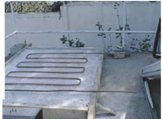
La pose de la grille de chauffe au-dessus de la prédalle
