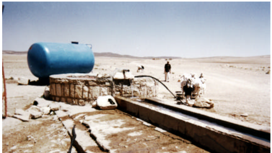
Pompage solaire photovoltaïque (Naama)
