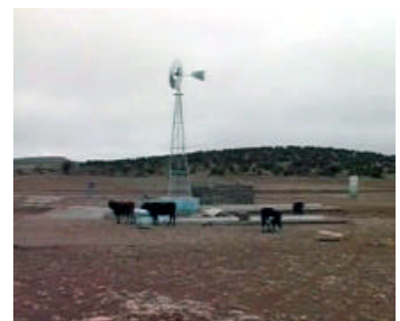
pompage éolien bir hlilef commune de maamoura willaya de saïda
