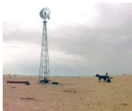
système de pompage éolien à la commune de douar el maa
