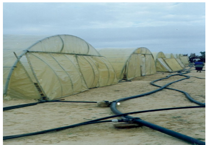
Chauffage des serres par énergie géothermique - W. Touggourt
