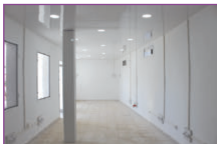
Figure 2: Eclairage du nouveau bâtiment de la Division Solaire Thermique et Géothermie.
