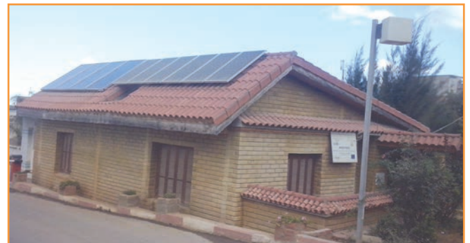
Figure 1: Vue générale de l'habitation pilote (Souidania, Alger) et les capteurs solaires thermiques et le générateur photovoltaïque installés sur le toit.
