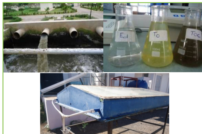
Figure 4: Epuration des eaux usées par distillation solaire (Brevet INAPI N° 120806, UDES 2011)
