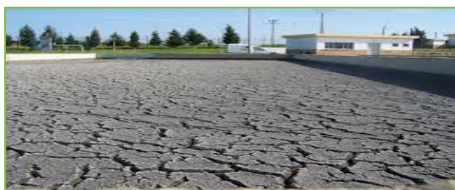
Figure 6: Lit de séchage solaire à l'air libre
