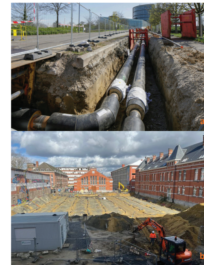
Figure 5. a) Réseau de chaleur par géothermie (Deep geothermal system), Champs-sur-Marne, France [4]; b) Réseau de chaleur par géothermie (Shallow geothermal system), Bruxelles Belgique [5].
