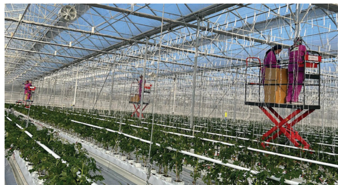
Figure 6. Serre chauffée par la géothermie, Istanbul, Turquie [6].
